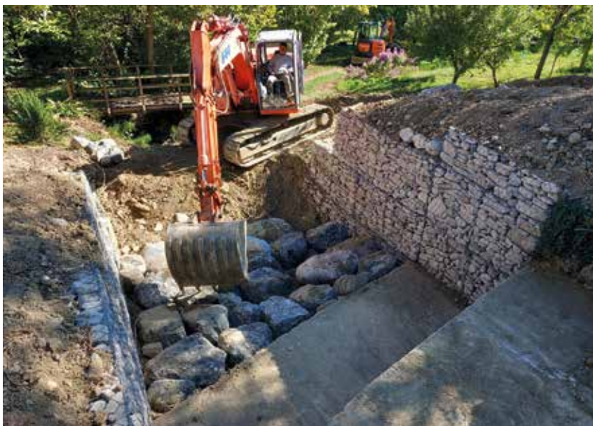
Regimazione idraulica e ripristino funzionalità fidei ossi di scolo in località Molino Stella, Piozzano
